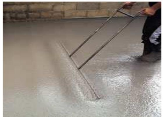
Figure 1 : Egalisation d'une chape après sa mise en place avec EURO NIV HP
