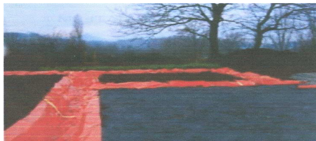
Photo de pose non contractuelle. Pose dans les fouilles, avant ferrailage et coulage du béton.
