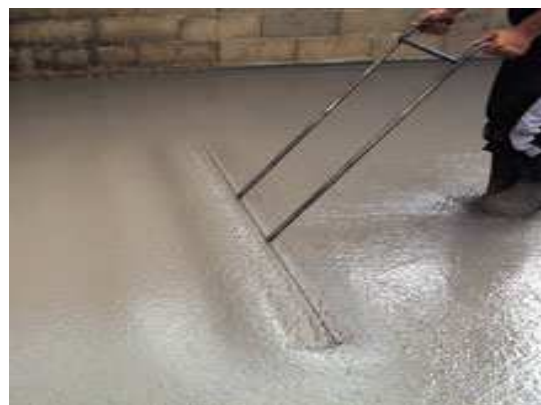
Figura 1: Regularização de uma betonilha após a sua realização com EURO NIV HP
